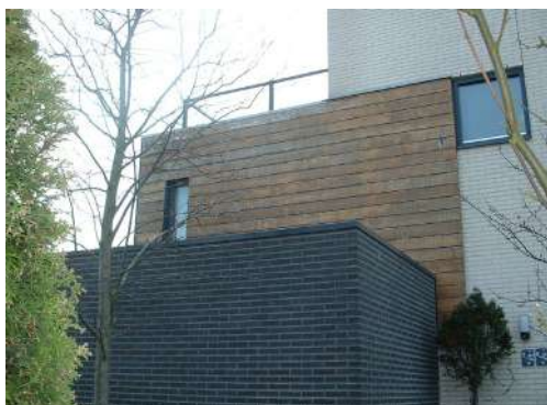
Afbeelding 3 Ongunstig: transparante afwerking.
