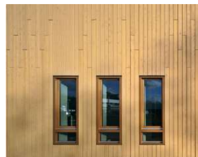
Afbeelding 2 Gevelbekleding in “wildverband”.
