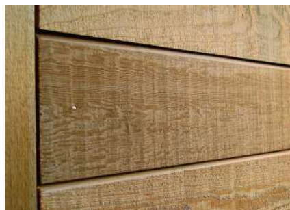
Afbeelding 1 Voorbeeld open gevelbekleding.
