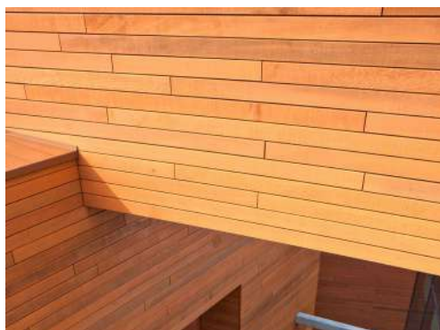
Afbeelding 4 Gunstig: 3 lagen kleurbeits op fijnbezaagd oppervlak.
