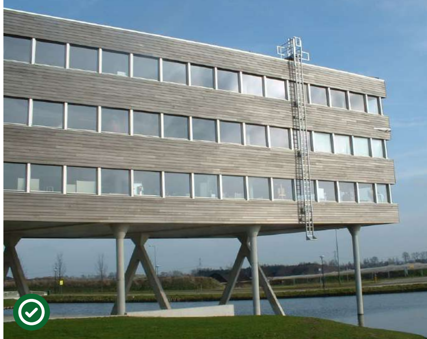
Afbeelding 13 + 14 Voor een gelijkmatige vergrijzing is het noodzakelijk dat de gevel gelijkmatig en voldoende aan weer en wind blootstaat.
