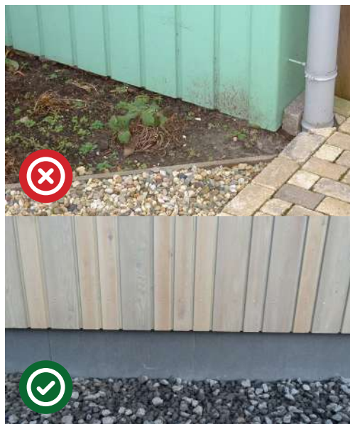
Afbeelding 11 + 12 Laat tussen hout en maaiveld bij voorkeur meer dan 300 mm afstand.
